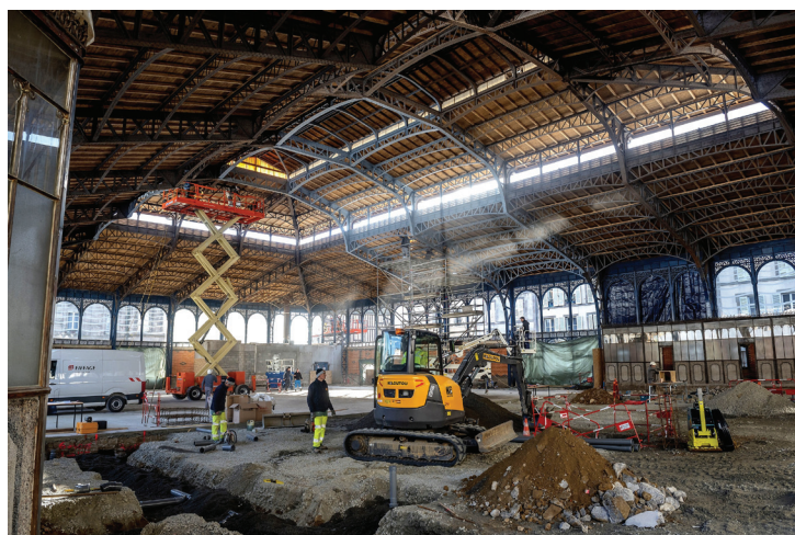
Chantier intérieur - janvier 2019 / © Ville de Limoges - Laurent Lagarde
