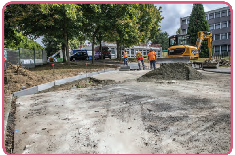
Travaux à l'école Jean-le-Bail
