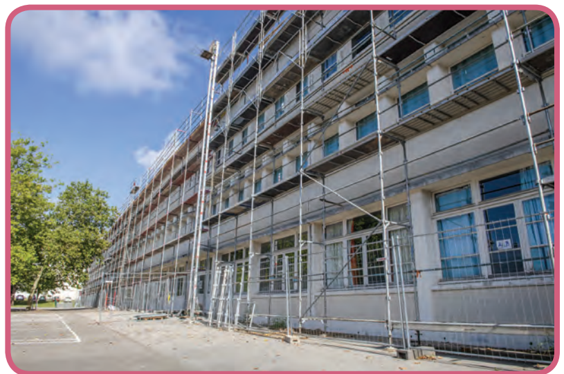
Travaux à l'école Léon-Blum
