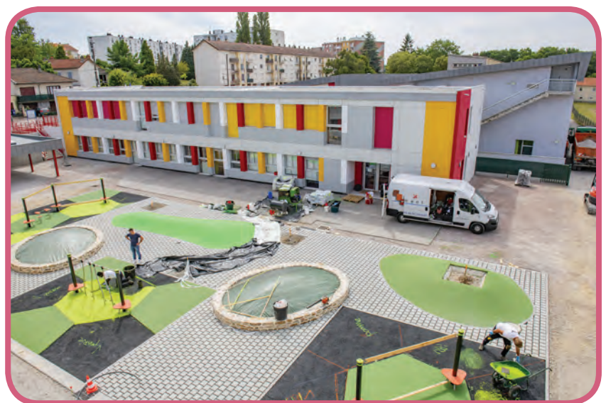
Groupe scolaire Condorcet-Roussillon : mise en place d'une aire de jeux
